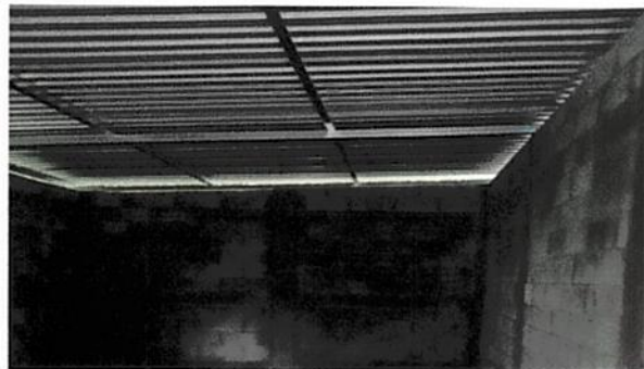
Foto 2: Sustitución de techo de madera por estructura metálica
