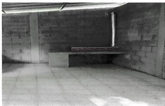
Foto 5: Colocación de piso
