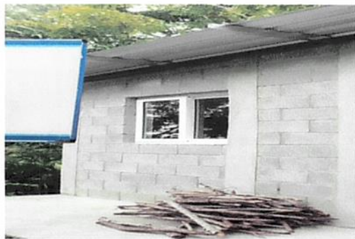
Foto 3: Instalación y sustitución de ventanas pvc
